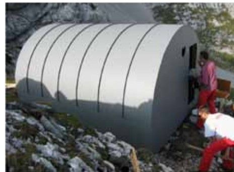
Bivak v Kočni po obnovi, foto arhiv Franca Markiča
