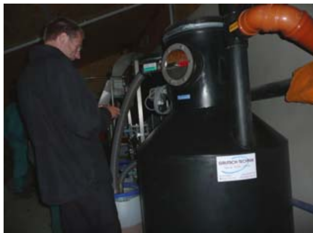
Slika 6 Izločevalca maščob
