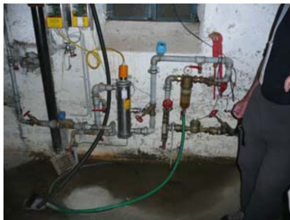
Slika 20 Dezinfekcija pitne vode
