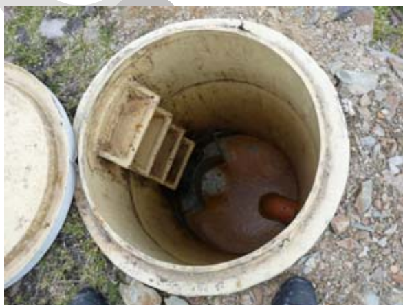
Slika 14 Izločevalec milnice
